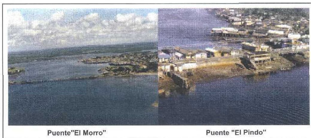
Fig. 7 Puente "El Pindo"
