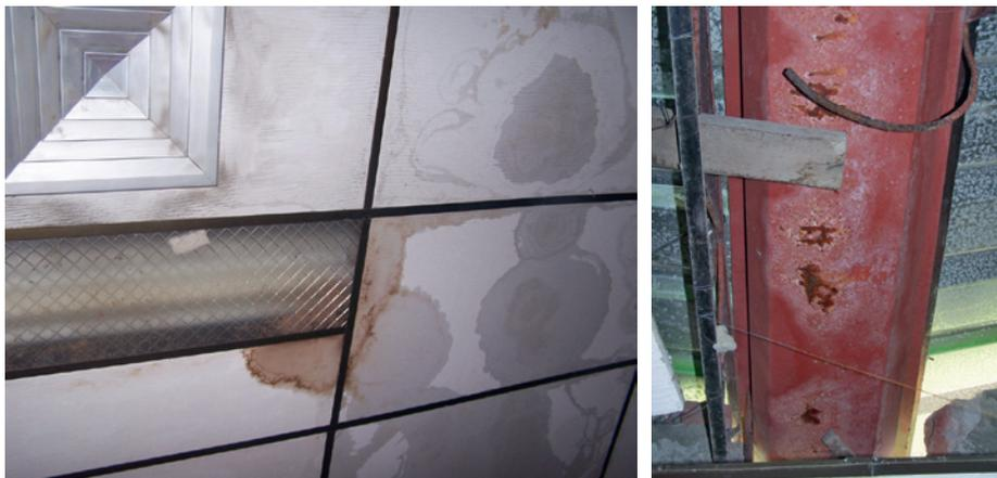
Figura 3. Efecto de las inundaciones causadas por el estado del sistema de conducción del agua lluvia que atraviesa el depósito del archivo y la biblioteca.
