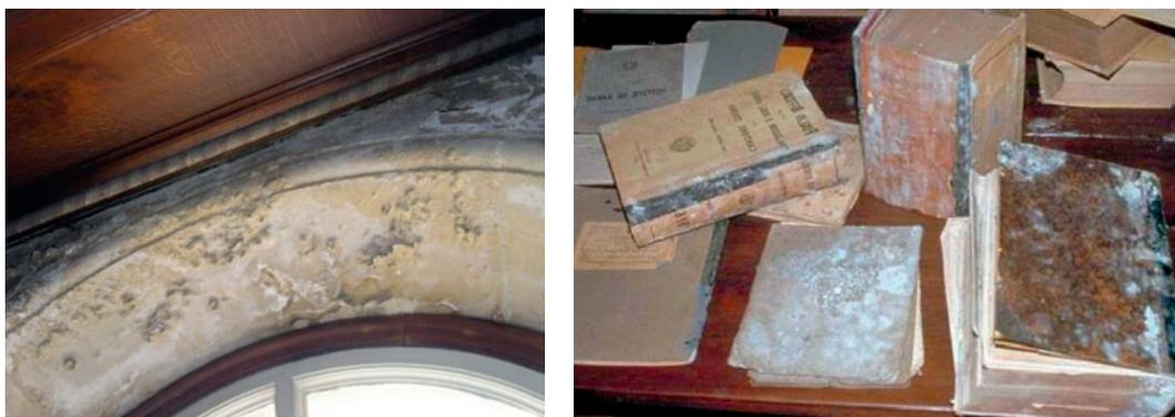
Figura 41. Salitre resultante del ascenso capilar de agua y de una tasa elevada de humedad.
