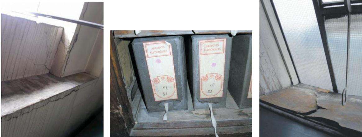
Figura 39. Muros agrietados que ocasionan infiltraciones. Cajas de conservación degradadas por caída de agua. Ventana no hermética que causa daños por el agua que se filtra.
