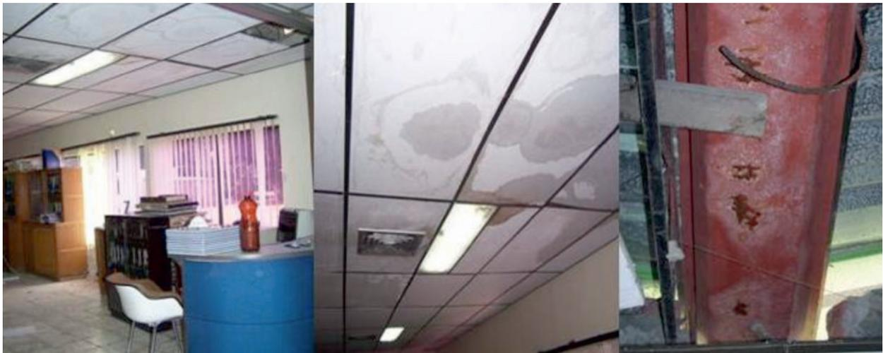
Figura 2. Panorámica interna del archivo. Deterioro del sistema de agua lluvia (canaletas).
