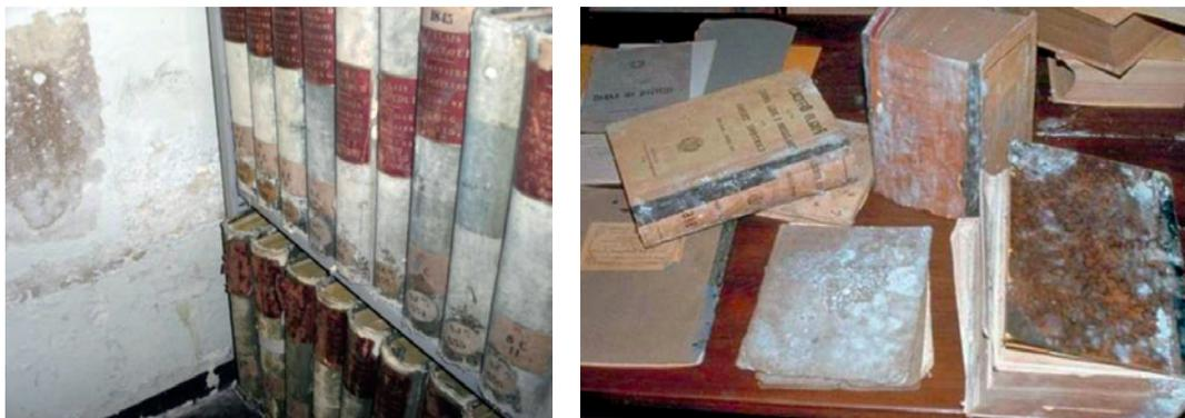
Figura 42. Mohos migrando de los muros a los registros. Infestación generalizada debida a variaciones de temperatura y humedad causadas por un daño de tuberías de agua.
