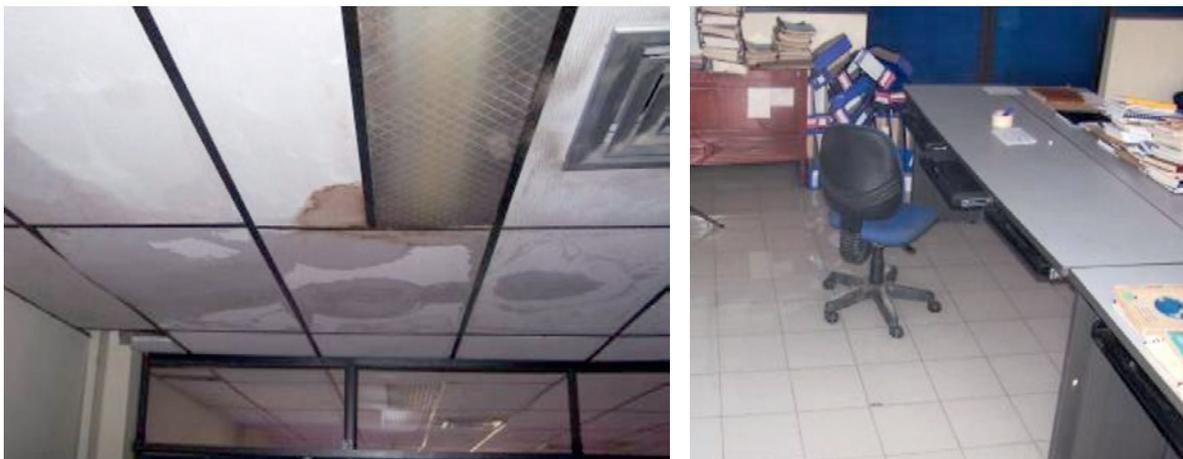
Figura 7a. Efecto de las inundaciones por el pésimo estado del sistema de conducción del agua lluvia que atravesaba el depósito del archivo y la Biblioteca del CCCP.
