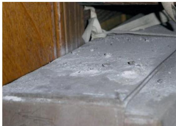
Figura 16. Depósito de polvo y yeso caídos del techo.
