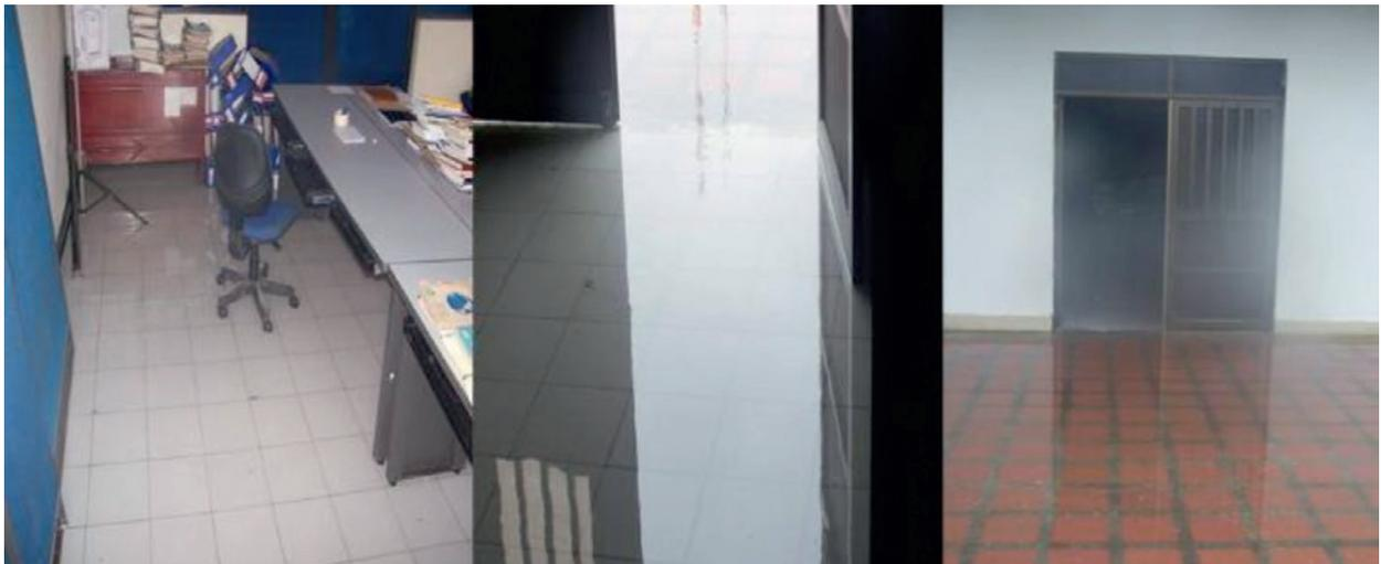
Figura 3. Efecto de las inundaciones por el pésimo estado del sistema de conducción del agua lluvia (canaletas) que atraviesa el depósito del archivo y la Biblioteca.
